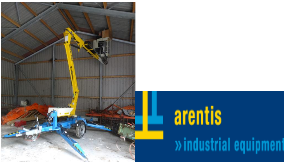
Foto Bram Vroegindeweij. Klussen met Arentis hoogwerker.
